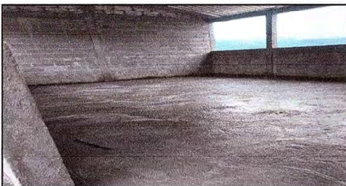
Foto 3: SUSTITUCION DE PISO DE AULAS 1 Y 2
