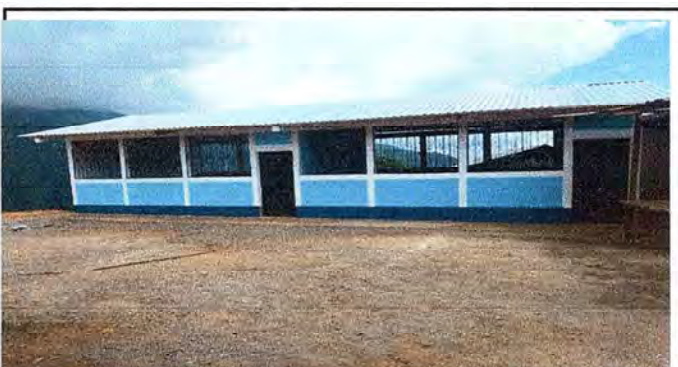
Foto 4: SUSTITUCION DE ENTRECHADO DE AULAS 1 Y 2
