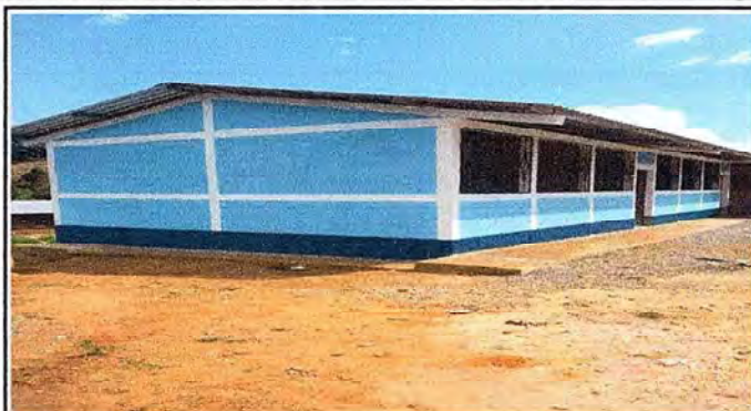
Foto 2: CULMINACION DE PAREDES DE AULAS 1 Y 2
