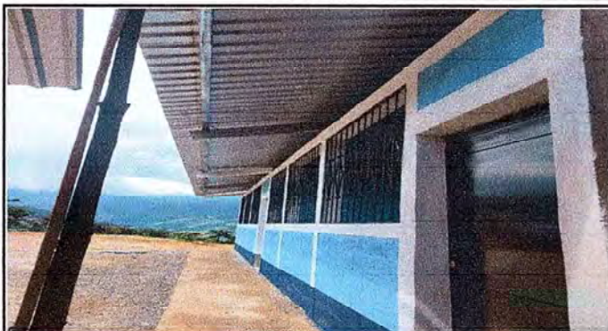
Foto 1: TERMINACION DE COLOCACION DE PUERTAS DE LAS AULAS 1 Y 2
